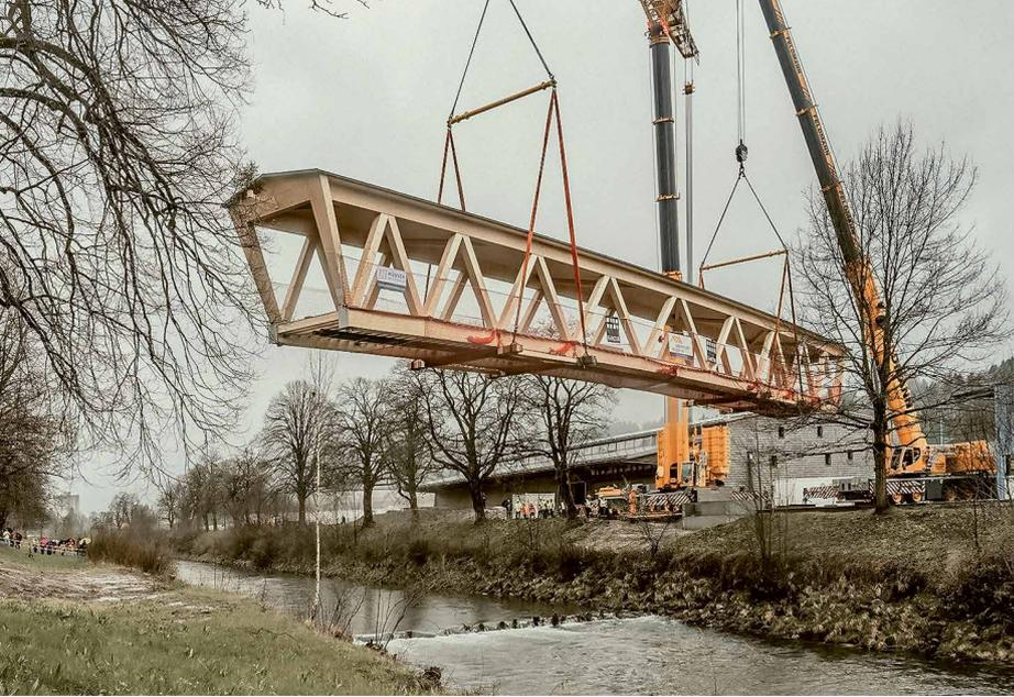
Das Brückeneigengewicht spielt eine wesentliche Rolle für das Bauverfahren und für die entsprechenden Kosten. Die lediglich 30 Tonnen schwere Fachwerkbrücke ermöglicht ein effizientes Bauverfahren und kann in einem einzigen Arbeitsschritt mithilfe von Mobilkränen eingehoben werden. Die einzelnen Elemente der Brücke werden vorgängig am Flussufer zusammengebaut.
