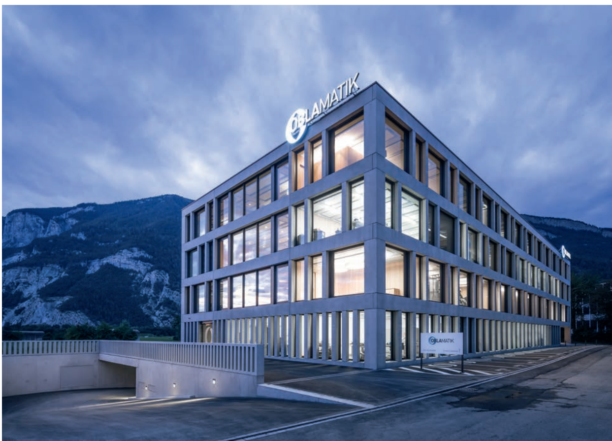
Das Innovations- und Technologiezentrum der Oblamatik AG auf dem Churer Rossboden bietet Platz für 100 Mitarbeitende. (Bild: Ingo Rasp)
