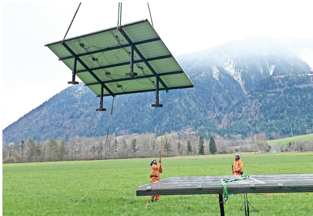
Montage mit Helikopter: Die vorbereiteten Panels werden auf dem Talboden bereitgestellt und von der Helicrew punktgenau an den Standort am Hang geflogen. (FOTOS NORBERT WASER)
