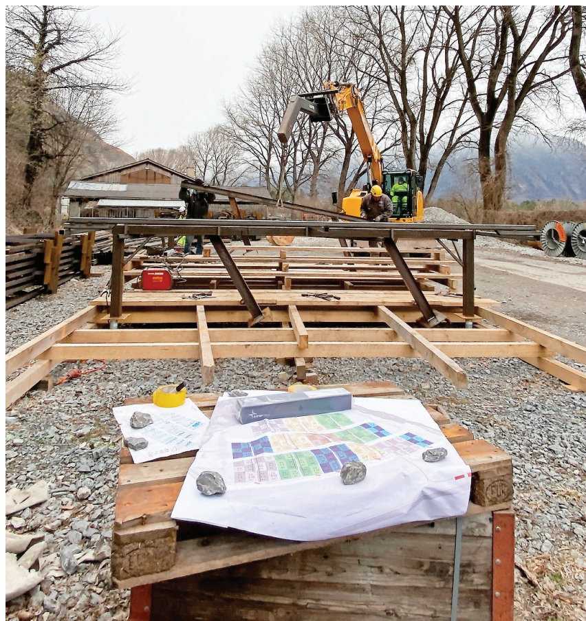
Die nächste Serie wird vorbereitet: Die Metallgestelle werden vor Ort zusammengesetzt und die Solarpanels darauf montiert. Im Hintergrund rechts die Aufschüttung .
