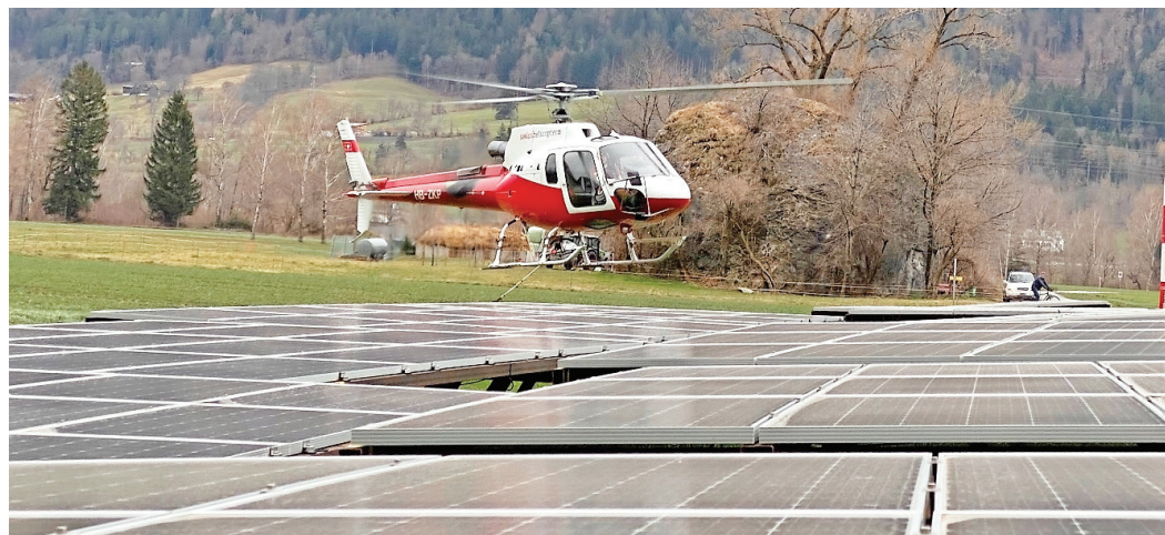
Montage mit Helikopter: Die vorbereiteten Panels werden auf dem Talboden bereitgestellt und von der Helicrew punktgenau an den Standort am Hang geflogen. (FOTOS NORBERT WASER)
