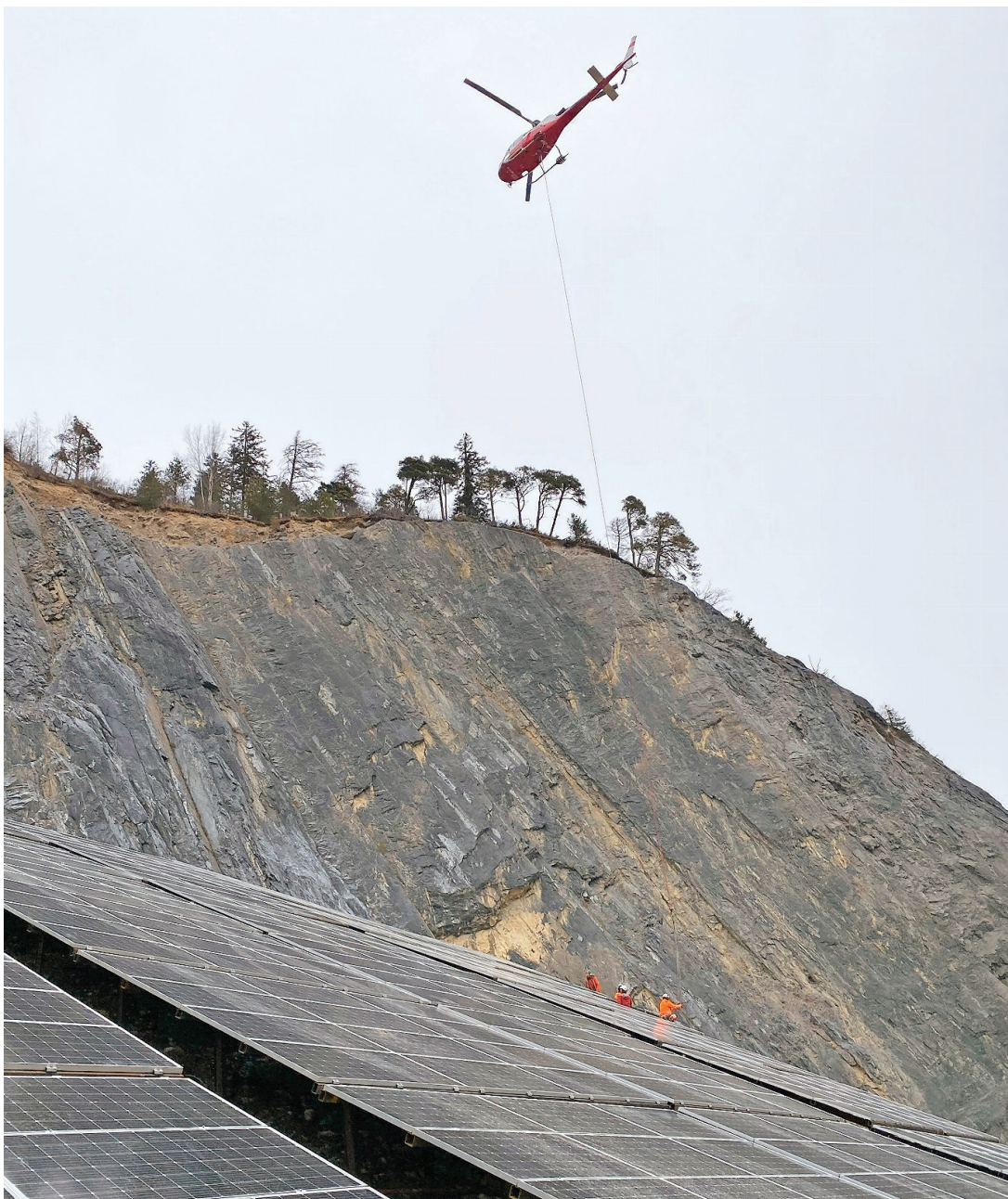
Montage mit Helikopter: Die vorbereiteten Panels werden auf dem Talboden bereitgestellt und von der Helicrew punktgenau an den Standort am Hang geflogen. (FOTOS NORBERT WASER)
