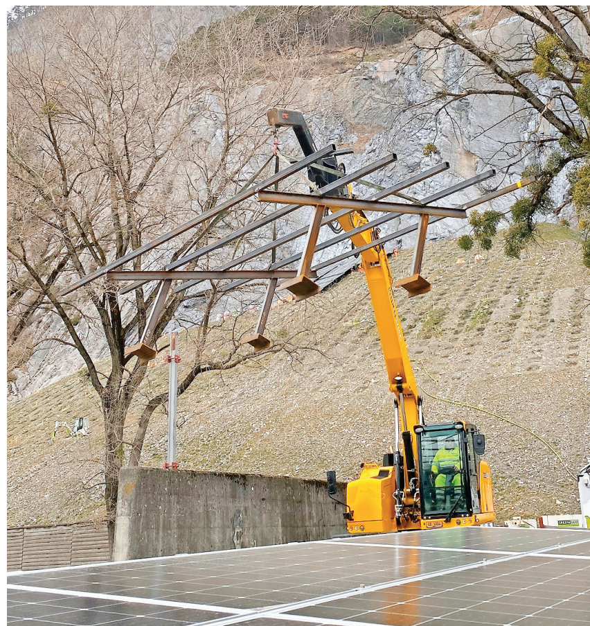
Die nächste Serie wird vorbereitet: Die Metallgestelle werden vor Ort zusammengesetzt und die Solarpanels darauf montiert. Im Hintergrund rechts die Aufschüttung .
