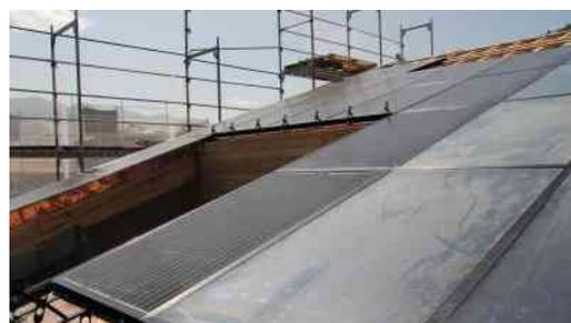
Beim Haus C stehen Sonnenkollektoren von Caotec und eine Photovoltaik-Anlage von Sunage nebeneinander im Einsatz.
