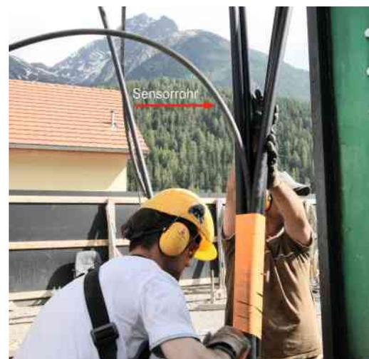
Zuerst wurden die Erdwärmesonden erstellt und bei drei der 20 Sonden Temperaturmessfühler in die Hinterfüllung eingebracht. (Bild: Vassella Energie GmbH)
