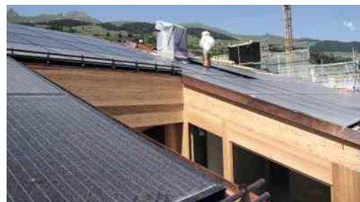
Photovoltaik- und Hybrid-Module sowie Sonnenkollektoren sind baugleich und werden in den Dächern integriert.
