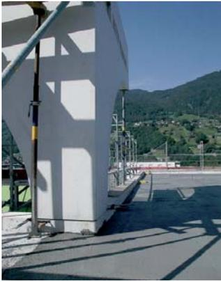
Die Elemente werden genau justiert und bis zum Einbau der Decke verstrebt und gestützt.
