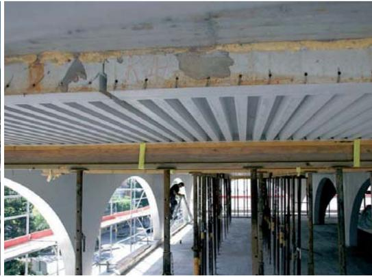
Die Deckenelemente dienen als verlorene Schalung im Bau und als Akustikdecken im Betrieb.
