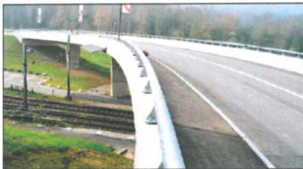
**175 Tonnen Armierungseisen, 520 Meter Vorspannkabel sowie 1500 Kubikmeter Beton wurden hier verarbeitet**
