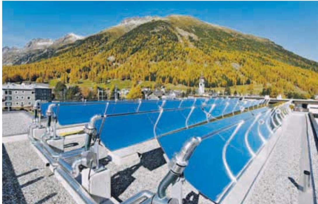
**Die Hochtemperatur-Kollektoren auf der höchstgelegenen Molkerei Europas werden zur Solardampferzeugung für die Milchproduktion eingesetzt. Auch dieses Projekt wurde mit dem Solarpreis 2012 ausgezeichnet.**
