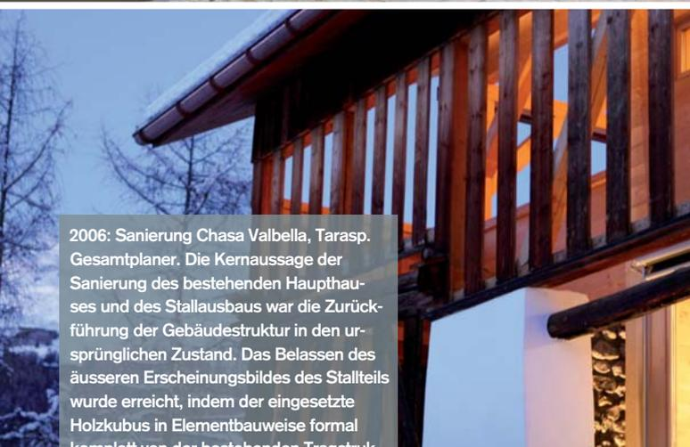
2006: Sanierung Chasa Valbella, Tarasp. Gesamtplaner. Die Kernaussage der Sanierung des bestehenden Haupthauses und des Stallausbaus war die Zurückführung der Gebäudestruktur in den ursprünglichen Zustand. Das Belassen des äusseren Erscheinungsbildes des Stallteils wurde erreicht, indem der eingesetzte Holzkubus in Elementbauweise formal komplett von der bestehenden Tragstruktur und der Fassade getrennt bleibt.
