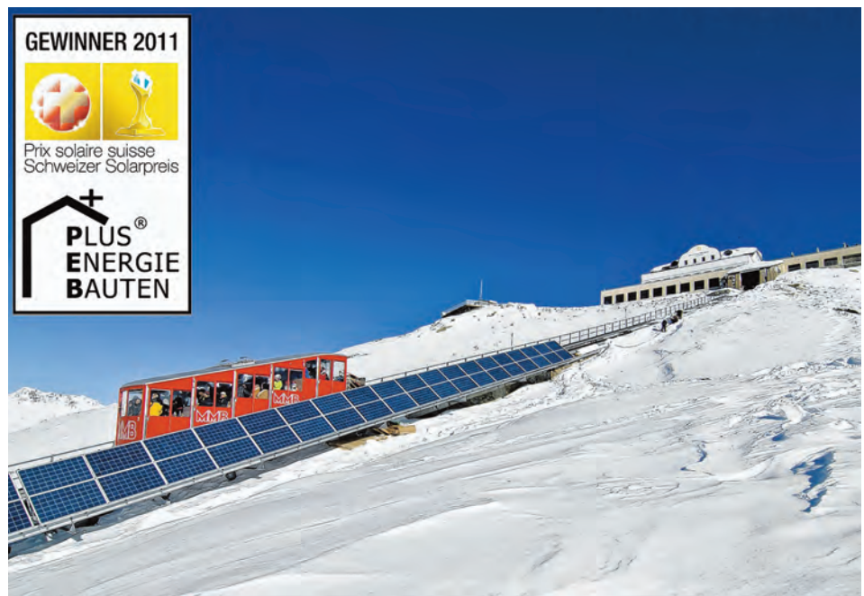
Die Photovoltaik-Anlage entlang dem Trasse der Standseilbahn.
