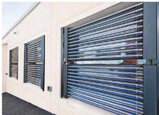
Fenster-integrierte Röhrenkollektoren. Diese liefern die Energie für das Warmwasser.
