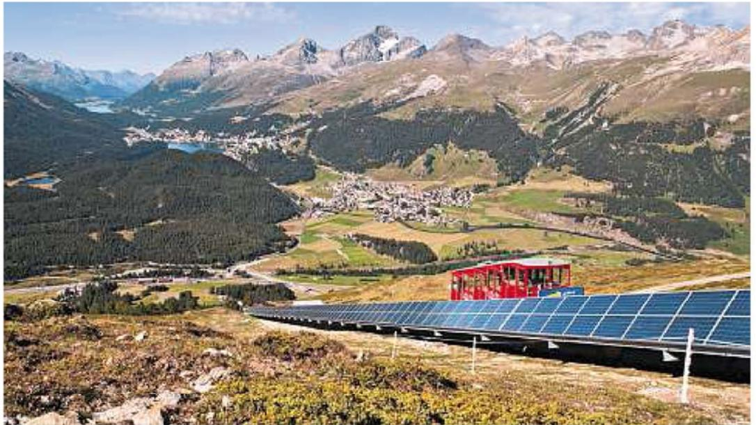
**228 Meter Panels am Stück:** Die Fotovoltaikanlage entlang der Standseilbahn nach Muottas Muragl versorgt das «Romantik Hotel» oben am Berg mit Strom.
