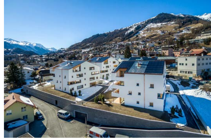
Die Überbauung, die 2020 fertiggestellt wird, bietet seit 2015 den Rahmen für das Projekt des Bundesamtes für Energie. (Bilder: Fanzun AG)
