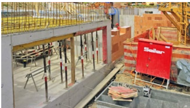
Garageneinfahrt mit Erdgeschoss Wohnhaus.
