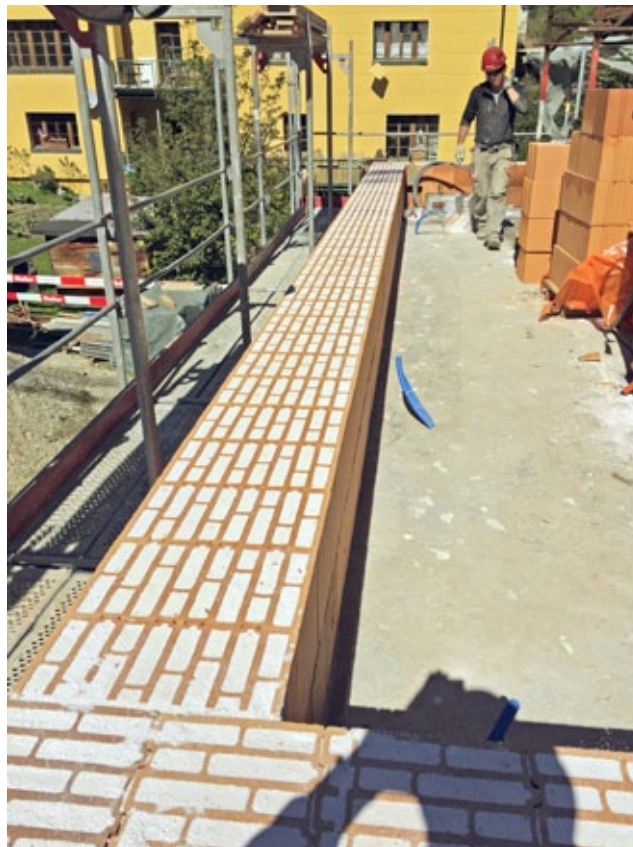
Das Mauerwerk wurde in Porotherm Stärke 42.5 cm erstellt. Das Wichtigste ist, dass die erste Schicht absolut perfekt im Blei liegt.
