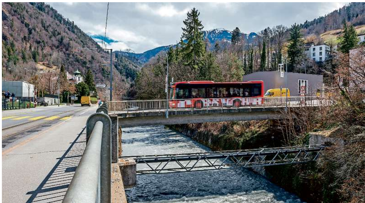
Aus zwei mach eins: Die heute separat geführten Wasser- und Stromleitungen werden in die neue Bodmerbrücke integriert, welche das heutige Bauwerk aus dem Jahr 1963 ersetzen wird. (FOTO YANIK BÜRKLI)
