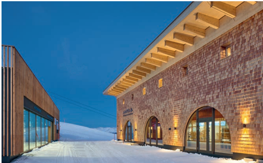
Die bergseitig geschindelte Fassade ist eine Wohltat fürs Auge. Mit konstruktivem Schutz und starken Trägern hält der Holzbau die harten Bedingungen auf 2150 Metern über Meer aus.
