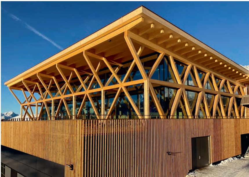
Über 50 Meter lang und ebenso breit ist das Gebäude. Der Sockel aus dem Bestand wurde mit Lärchenlatten eingekleidet. Über den Garagentoren sind PV-Module montiert.
