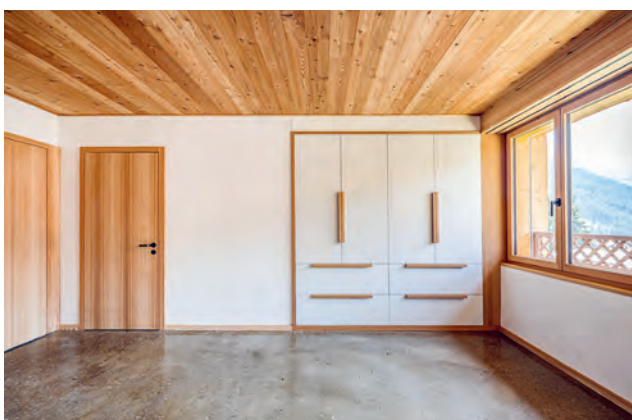
Stampflehböden, Lehmputz und viel Sichtholz machen die geräumigen Individualzimmer wohnlich.
