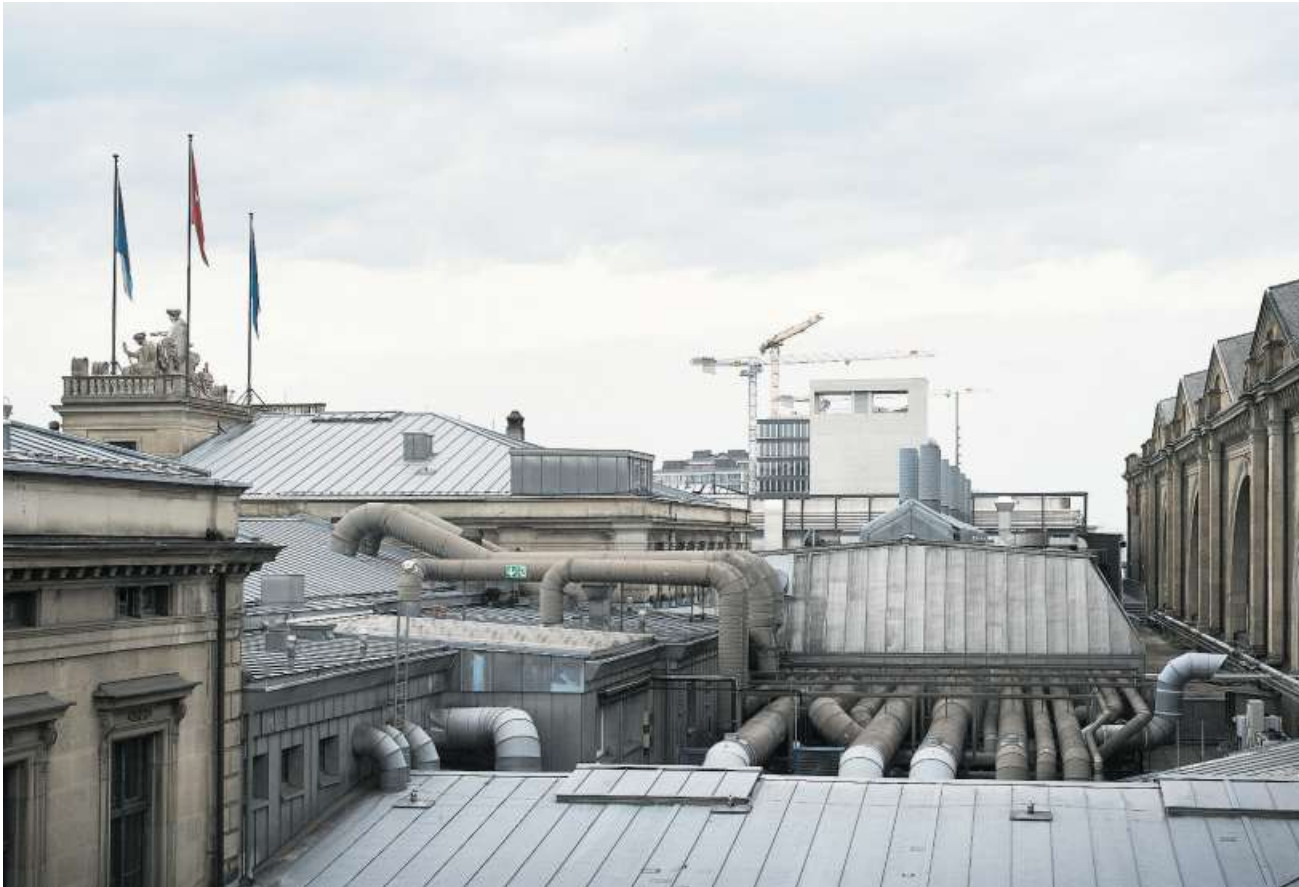
Die Entlüftungsrohre der Gastronomiebetriebe auf dem Dach des HB-Südtraktes weichen einer Glasüberdeckung. GORAN BASIC / NZZ
