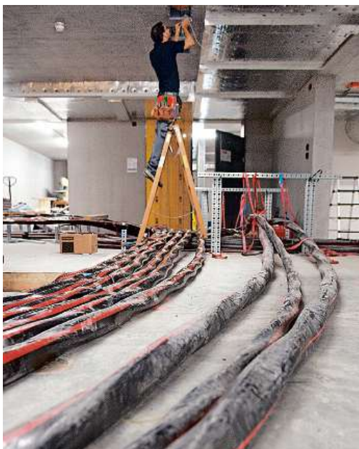
Einblick ins beeindruckende Innenleben des neuen Unterwerks Quader: Bis zur Inbetriebnahme der neuen Schaltanlagen (Mitte) müssen noch kilometerweise neue Leitungen verlegt und Kabel eingezogen werden. Die Hoch- und Mittelspannungsleitungen (links) werden in einem doppelten Boden verlegt.
