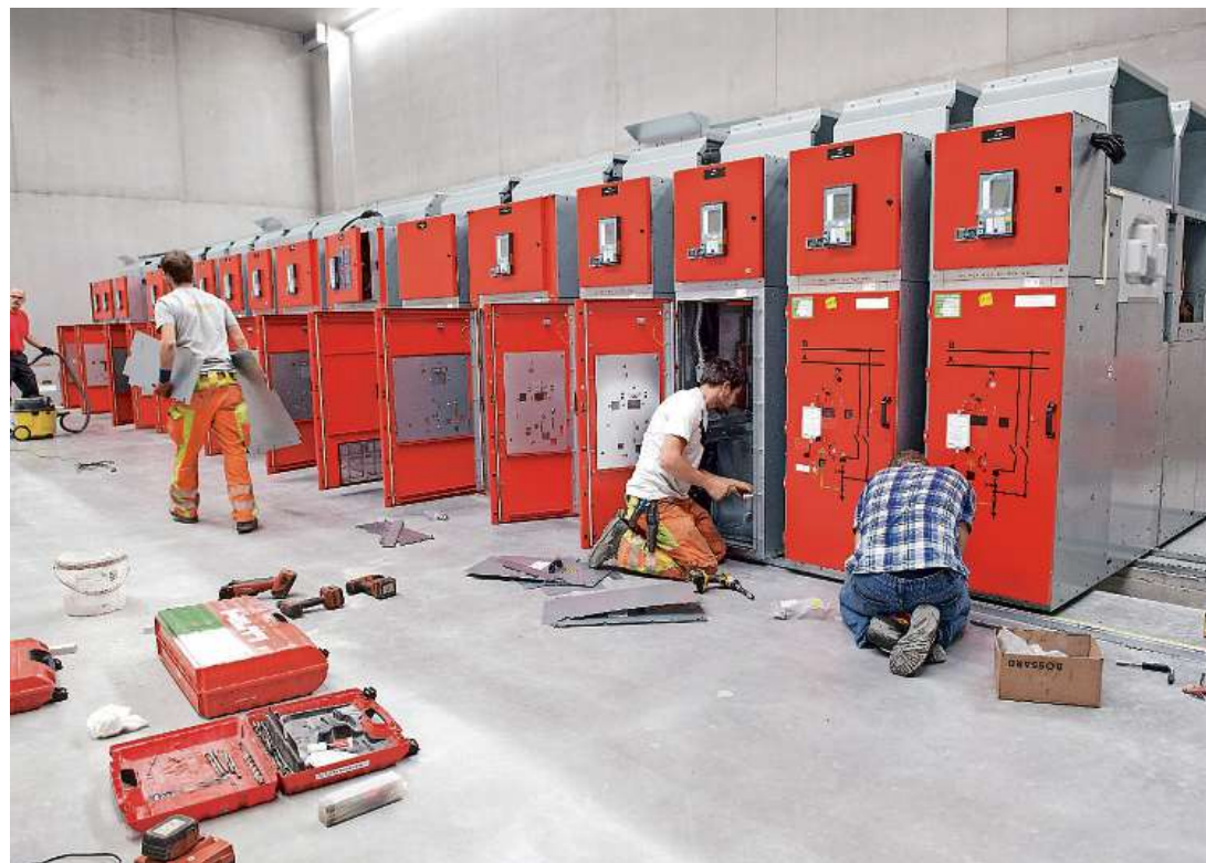
Im neuen Unterwerk Quader der IBC in Chur wird auf Hochtouren am Innenausbau gearbeitet: Im Bild der Einbau der Mittelspannung Schaltanlage für die lokale Stromversorgung. (FOTO OLIVIA ITEM)
