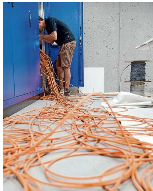
Einblick ins beeindruckende Innenleben des neuen Unterwerks Quader: Bis zur Inbetriebnahme der neuen Schaltanlagen (Mitte) müssen noch kilometerweise neue Leitungen verlegt und Kabel eingezogen werden. Die Hoch- und Mittelspannungsleitungen (links) werden in einem doppelten Boden verlegt.
