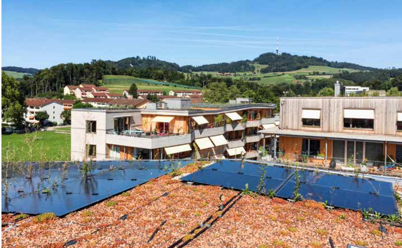
Die Wohnbaugenossenschaft Oberfeld in Ostermundigen (BE) gehört zu den genossenschaftlichen Pionieren, die PVT-Hybridkollektoren nutzen; diese produzieren gleichzeitig Strom und Wärme. In ihrer 2014 fertiggestellten Siedlung ist eine 1360 Quadratmeter grosse Anlage installiert.
