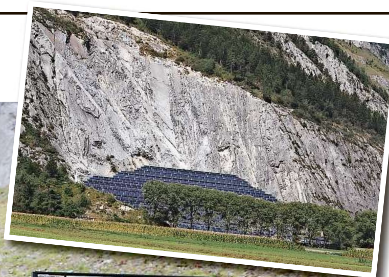
Dem Regen getrotzt: Per Sandven, Urs Simeon, Markus Feltscher und Peter Camastral (von links) auf der Baustelle.
