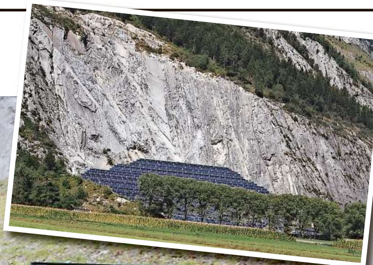
Dem Regen getrotzt: Per Sandven, Urs Simeon, Markus Feltscher und Peter Camastral (von links) auf der Baustelle.
