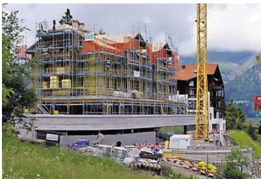
Der Umbau des « Alpina Mountain Resort & Spa » in Tschierschen läuft auf Hochtouren. (FOTO ZVG)
