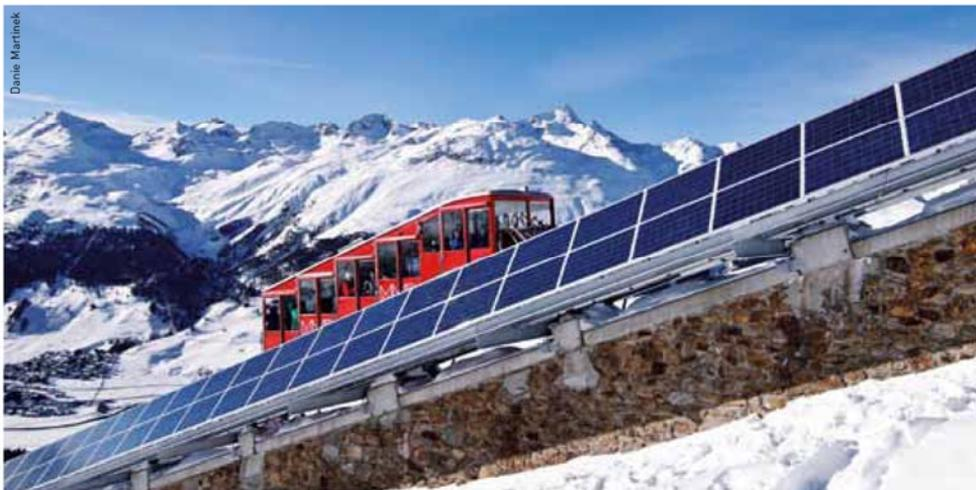
Les panneaux photovoltaïques de 64 kWc installés sur le tracé du funiculaire « Muottas Muragl » produisent chaque année quelque 94'600 kWh d'électricité par an (208 kWh/m<sup>2</sup>a).
