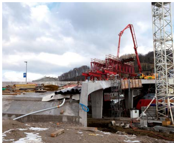
Das Betonieren des Mittelfelds vollendet das monolithische Bauwerk
