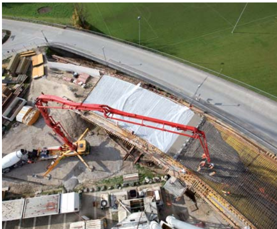
Die neue Brücke verläuft auf der Kurveninnenseite der alten Zufahrt
