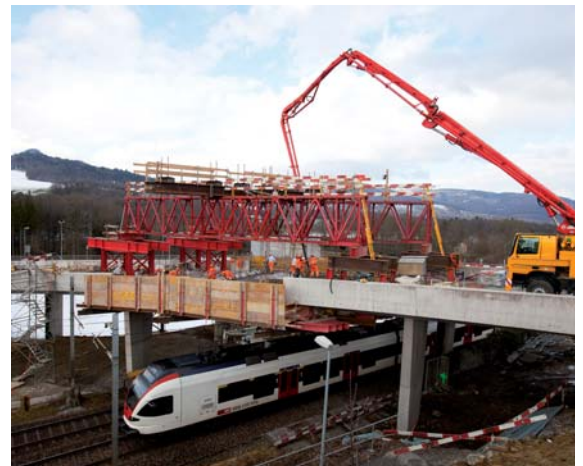
Die neuen Pfeiler stehen in sicherem Abstand von der Bahnlinie
