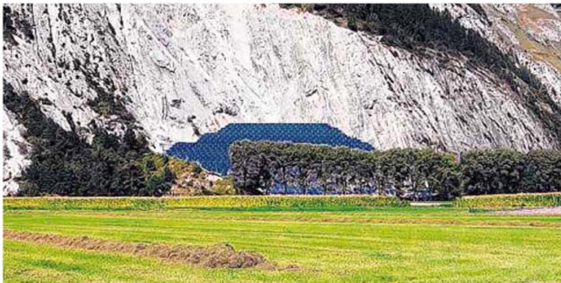
Ein Vorhaben für die Zukunft: Im Steinbruch Calinis in Felsberg soll ein Sonnenkraftwerk entstehen.
