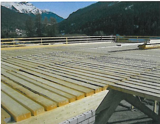
Planerisch dargestellt (gesamt und im Detail) sowie in der Ausführung: die BSH-Fachwerkträger mit einer Decklage aus Vollholz-Querschnitten (auf Lücke) bzw. Werkstoffplatten.
