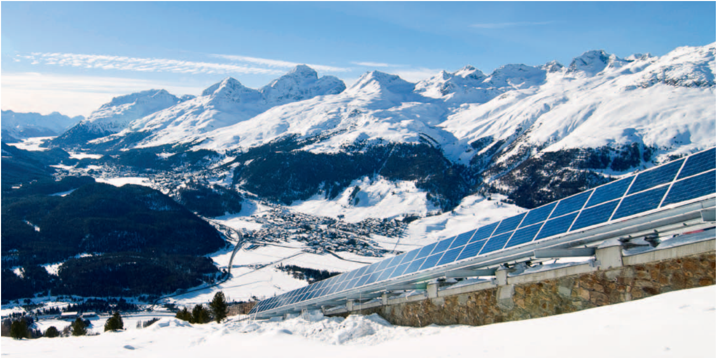
Sonnenkollektoren entlang des Trasses der Standseilbahn
