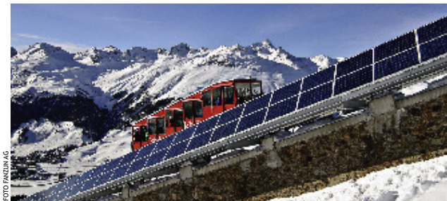
Die Kombination von Stromerzeugung und Bahntrasse bietet installationstechnische Vorteile.
